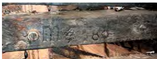
De balk met daarin het originele brandmerk is na de restauratie behouden gebleven (zie blz. 90).
