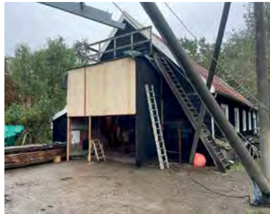
De deurconstructie gemaakt om ruimte te creëren.
